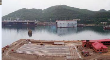
2006年サイダ湾で稼働を開始した陸上保管施設（左上）と同時期の極東ラズボイニク湾の陸上保管施設建設現場（右下）
